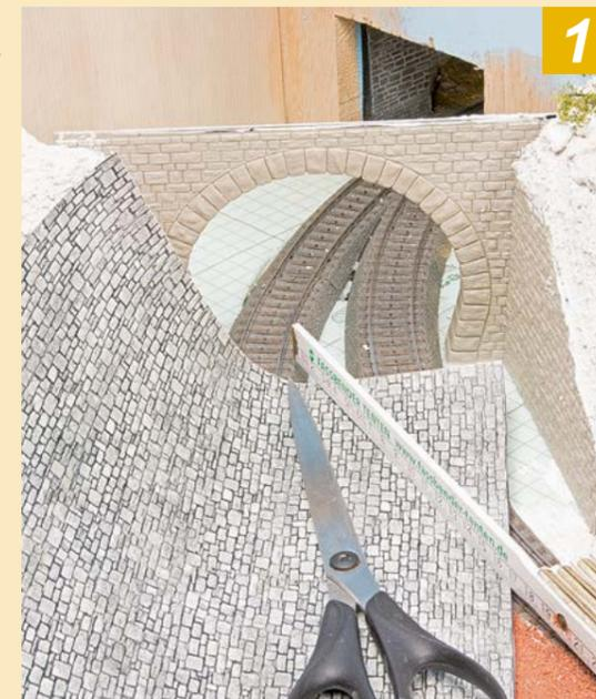
**Die Breite des Heki-Kartons entspricht fast genau dem Umfang des Tunnelmundes, weshalb dieser den Startpunkt bildet. Überschüssiges Material wird in den Durchbruch im Hintergrund eingeschoben.**
